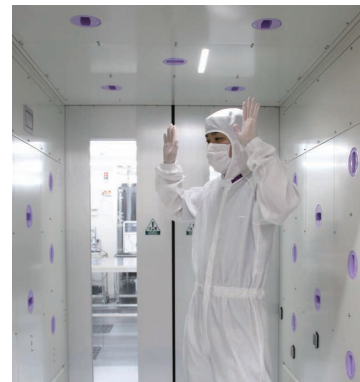
エアシャワーで塵やゴミを除去
