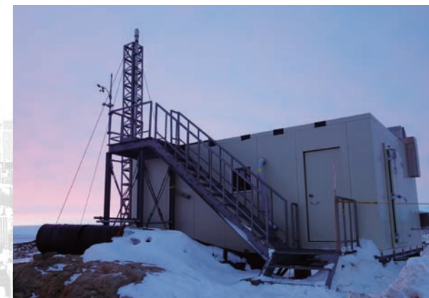
図2 エアロゾルの観測を行っている昭和基地の清浄大気観測室(AOH)。左側のタワー上部から空気を室内に引き込む
